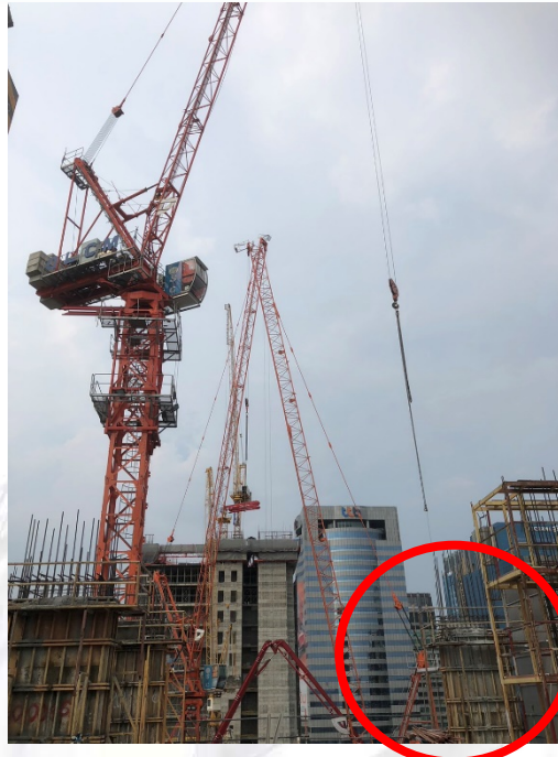
ภาพที่ ๒.๗.๒ ภาพการตั่งนั้งร้านเพื่อเทคอนกรีตเสาอาคาร
