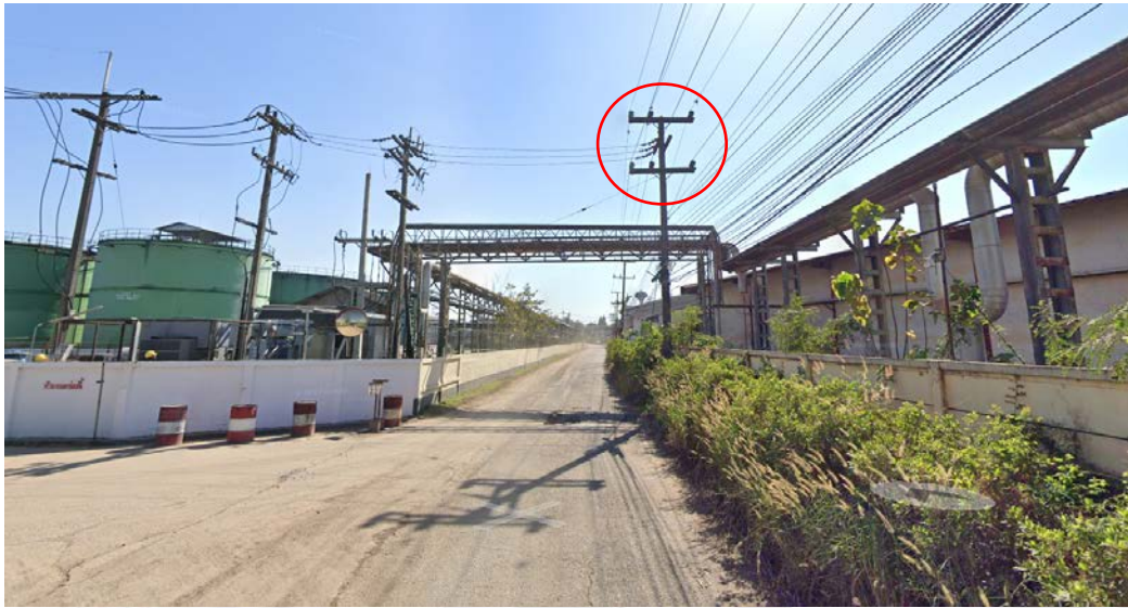
ภาพการติดตั้งคอนแทกกรับสายไฟจากผู้ขายไฟ
