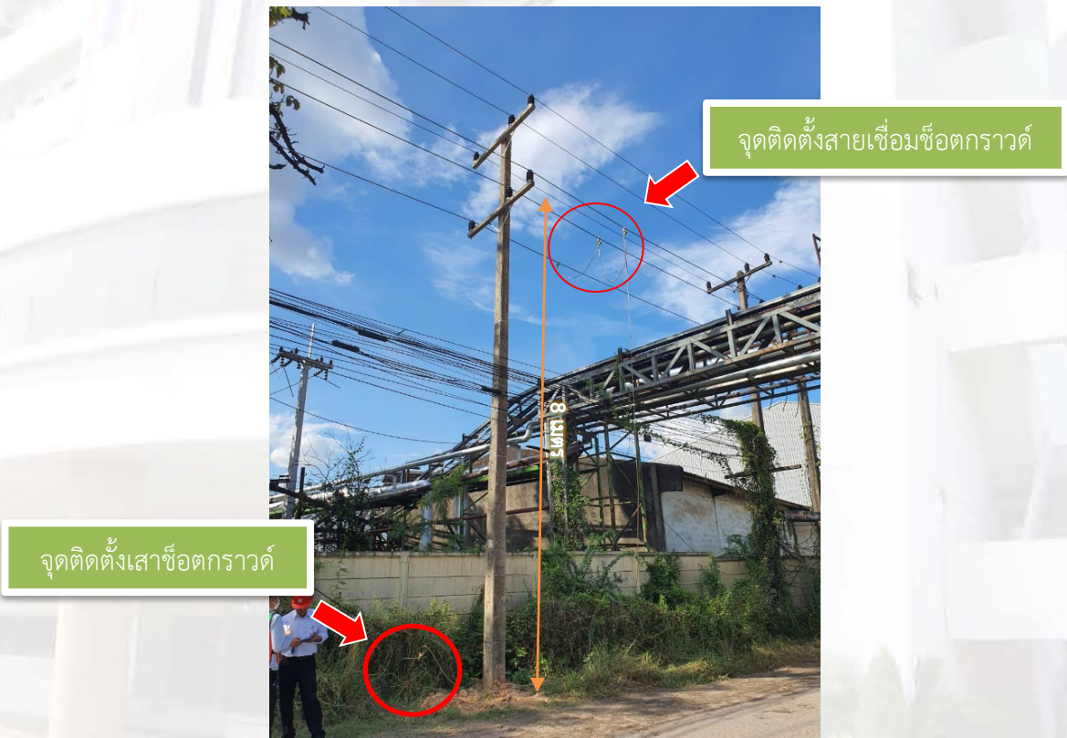
สถานที่ปฏิบัติงานเป็นเสาไฟฟ้าแรงสูง แรงดันไฟฟ้า ๒๒ kv ความสูงจากพื้นดินถึงจุดปฏิบัติงานประมาณ ๘ เมตร ระยะห่างระหว่างคอนกรีตชั้นบนและชั้นล่างประมาณ ๒ เมตร
