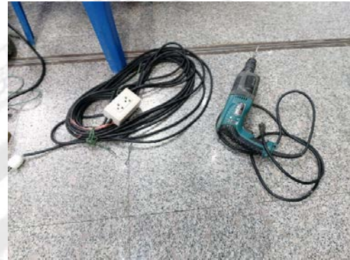
รูปปลั๊กพ่วงสายไฟฟ้าเส้นที่ ๒ พร้อมเครื่องสว่านที่ใช้เจาะ
