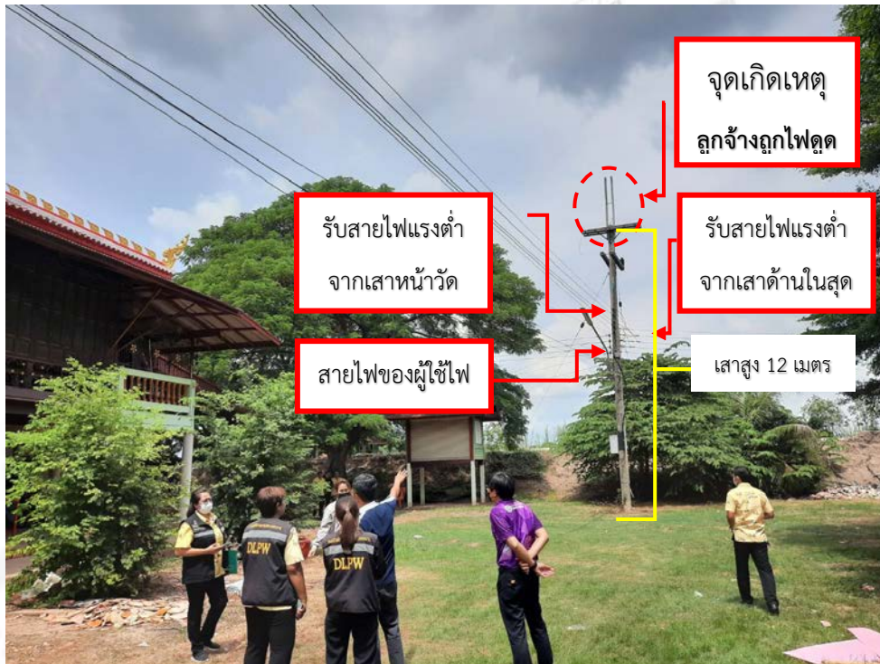
รูปภาพที่ ๑ แสดงบริเวณสถานที่เกิดเหตุลุกจ้ำงถูกไฟฟ้าดูด
