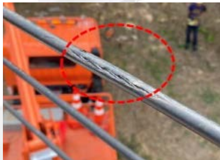
รูปภาพที่ ๖ แสดงจุดที่สายไฟหลุด
