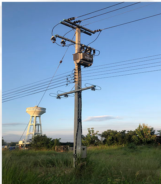
รูปภาพที่ ๖ แสดงลักษณะการเชื่อมต่อสายไฟฟ้าจากหม้อแปลงไฟฟ้าไปยังสายไฟฟ้าแรงสูง
