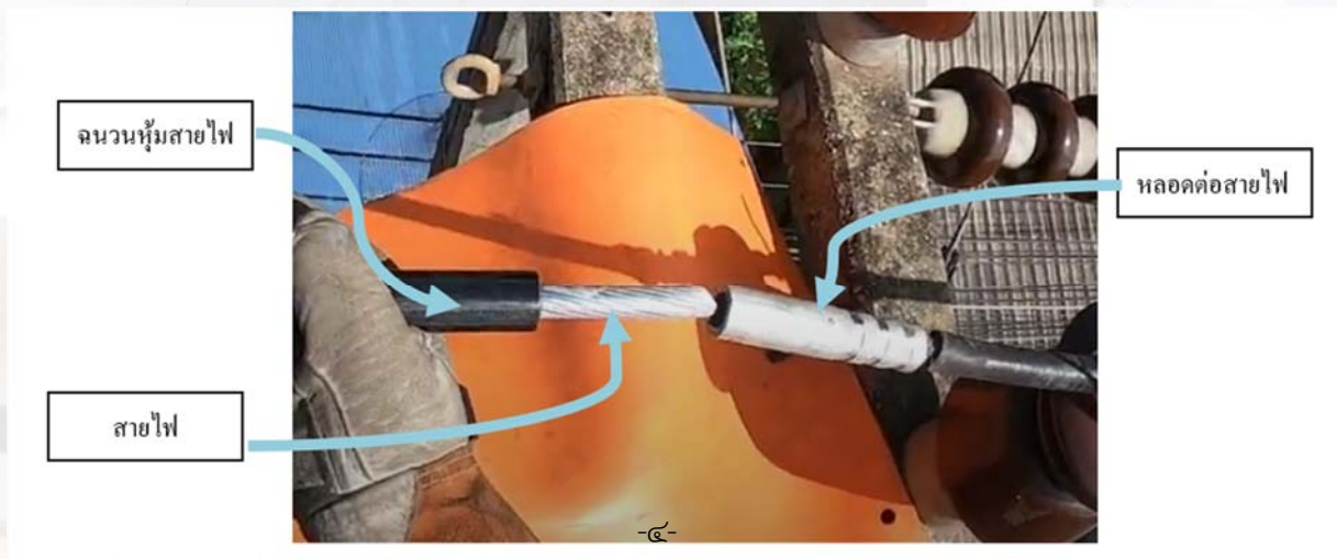
รูปที่ ๒ การต่อสายไฟฟ้าแรงสูง
