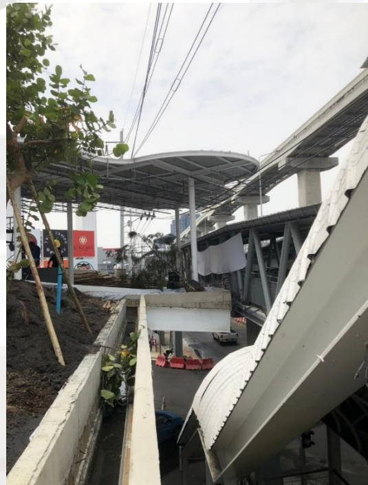
ภาพที่ ๒.๓.๖ สายไฟฟ้าแรงดัน ๖๙ kV เฟสบี ชนิดไม่มีฉนวนหุ้ม (อยู่ใกล้กับที่เกิดเหตุมากที่สุด) ที่กิ่งไม้อาจเข้าใกล้ในระยะไม่ปลอดภัยหรือสัมผัสสายไฟโดยตรง
