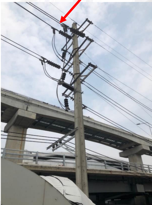
ภาพที่ ๒.๓.๖ สายไฟฟ้าแรงดัน ๖๙ kV เฟสบี ชนิดไม่มีฉนวนหุ้ม (อยู่ใกล้กับที่เกิดเหตุมากที่สุด) ที่กิ่งไม้อาจเข้าใกล้ในระยะไม่ปลอดภัยหรือสัมผัสสายไฟโดยตรง
