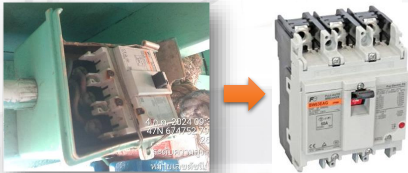
ภาพที่ ๒ เบรกเกอร์-แมกเนติก ยี่ห้อ FUJI รุ่น BW๖๓EAG ๓P ๖๓A
