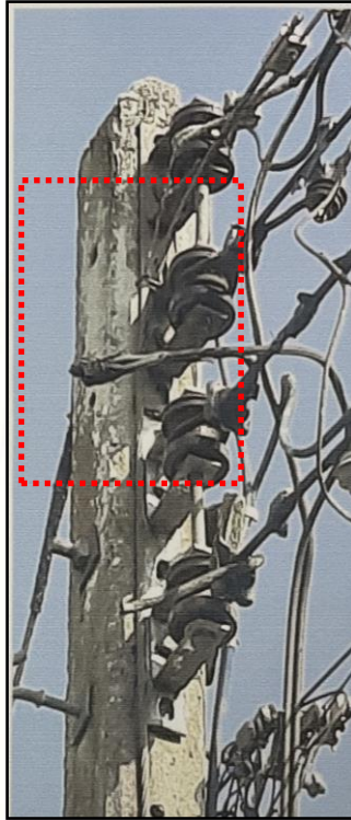
ภาพ : บริเวณสายไฟฟ้าจุดที่ฉนวนสายไฟชำรุด
