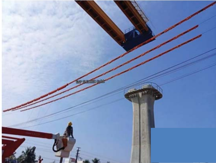
รูปภาพที่ ๙ แสดงตัวอย่างการใช้ฉนวนหุ้มกันกระแสไฟฟ้า
