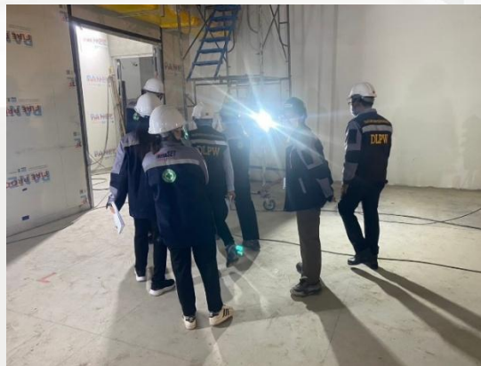
รูปที่ ๔ พนักงานตรวจความปลอดภัย เข้าตรวจติดตามการดำเนินการปรับปรุงแก้ไข
