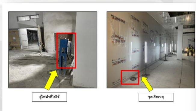
รูปที่ ๒ พื้นที่ปฏิบัติงาน ภายในอาคารก่อสร้าง อาคาร ๓ ชั้น ๓
