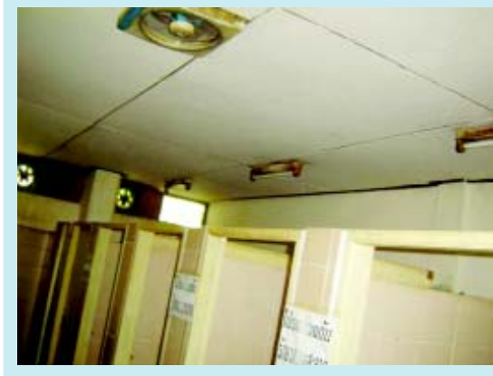
ภาพก่อนการปรับปรุง
